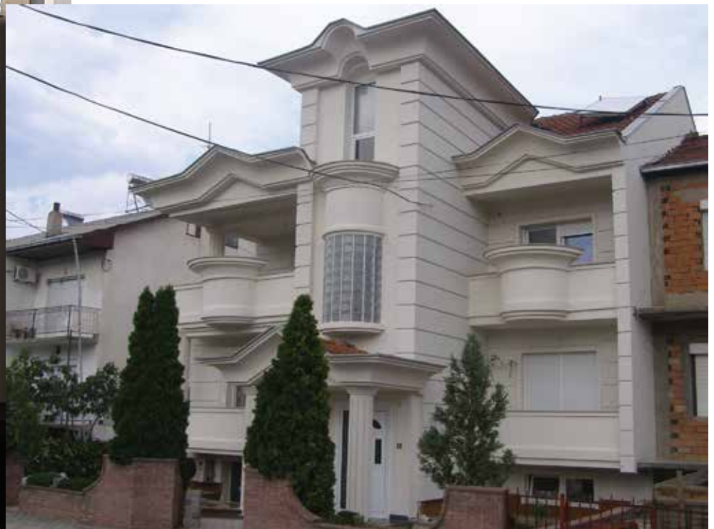
Објект Кавадарци - Jubizol /камена волна/Jubizol Uniwool, Jubizol Silikon Finish S 1.5mm (1135), изведувач Уметност Идеа-Вевчани
