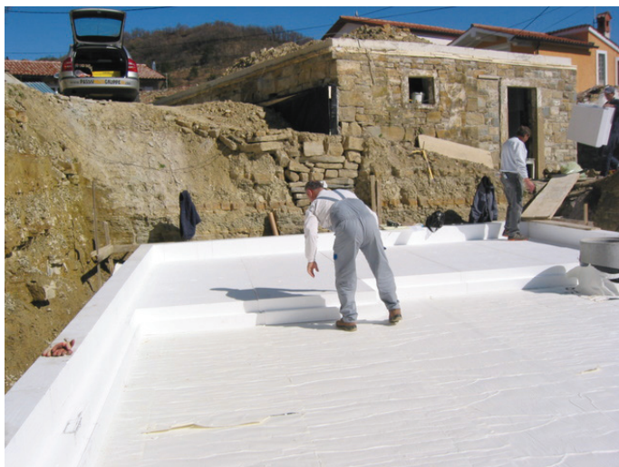
Vgradnja toplotno izolativne blazine iz EPS pod temeljno ploščo v slovenski Istri. Vir: Varčna gradnja d.o.o.
