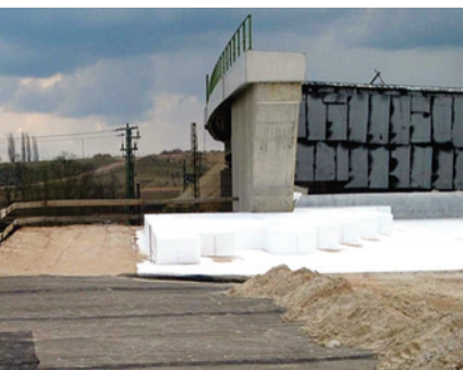
Uporaba EPS blokov namesto gruščnatega nasipa do nadvoza na AC Frankfurt/Oder. Vir: BAST Inštitut, Nemčija
